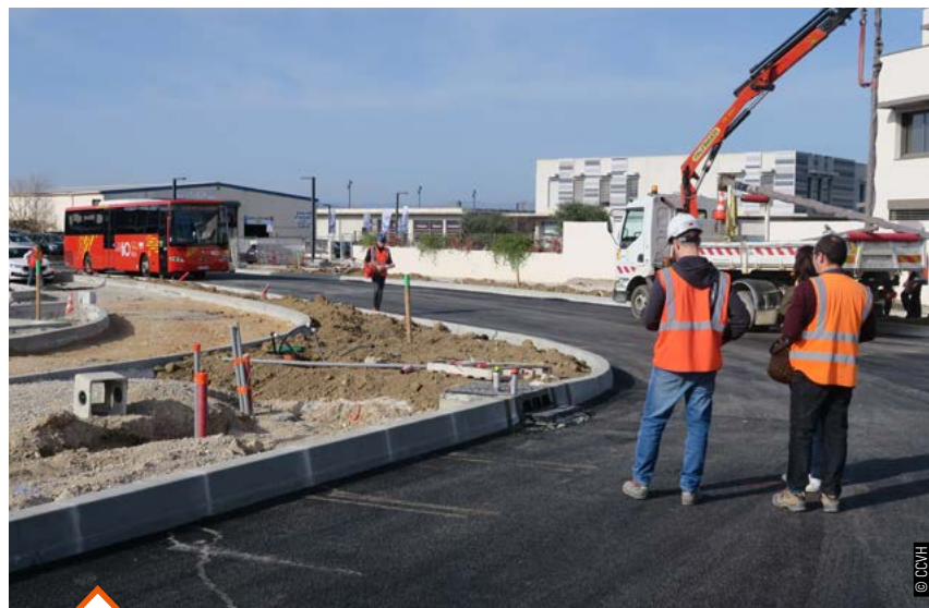
Après 1 an de chantier, le PEM sera opérationnel, pour le fonctionnement des bus, à partir du 27 mai 2024.
