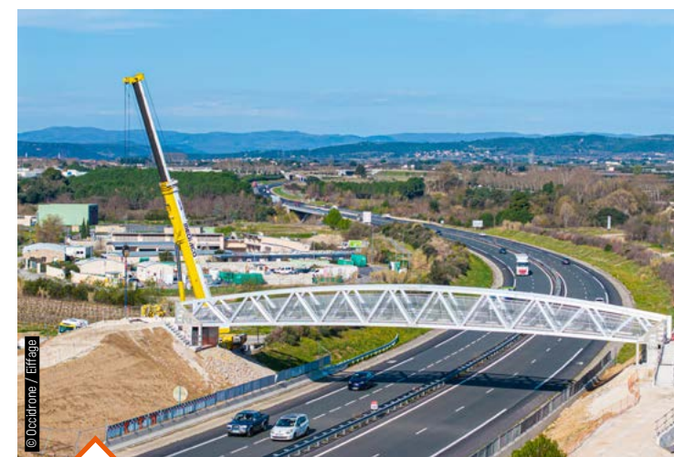
La passerelle est un ouvrage construit par Eiffage et Metalu.
