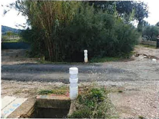
Figure 109 : cannes de Provence risquant de boucher l'ouvrage
