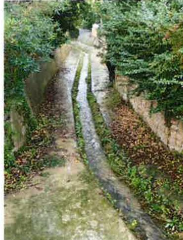
Figure 53 : lit bétonné dans la traversée de Popian
