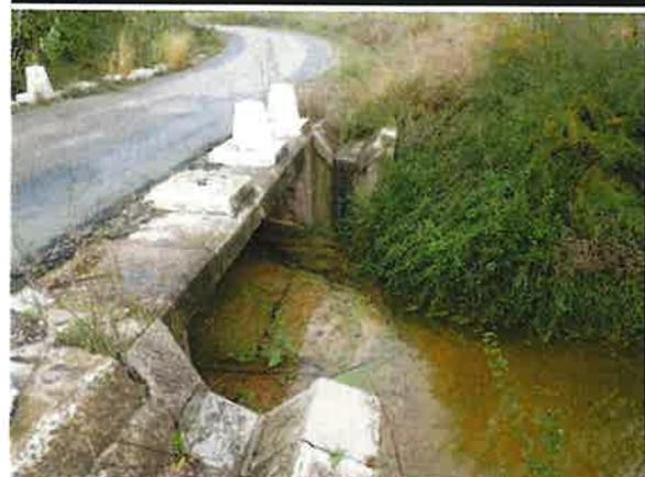
Figure 73 : pont submersible de la RD123 à Bélarga
