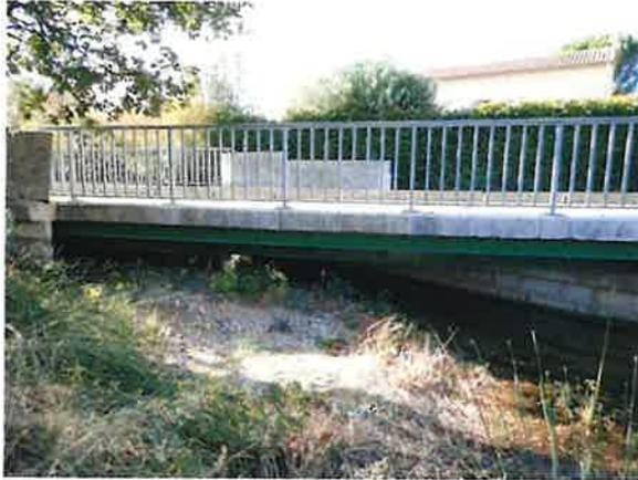
Figure 18 : tablier très bas et tendance au dépôt du fait de la grande largeur du lit
