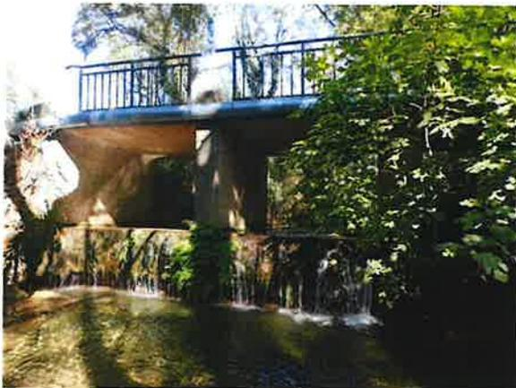
Figure 154 : radier du pont affouillé
