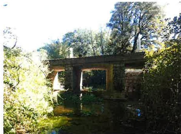
Figure 22 : risque important d'embâcle au pont de la RD9E2 et risque d'effondrement du pont du fait de l'incision en aval
