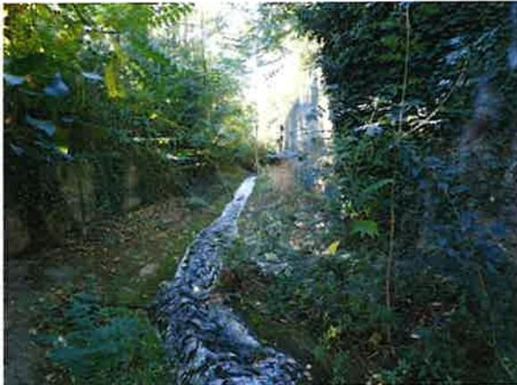
Figure 34 : arbre poussant dans la cunette béton dans la traversée de St-André-de-Sangonis
