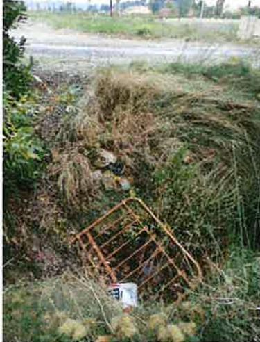
Figure 106 : encombrant et déchets risquant de boucher le pont
