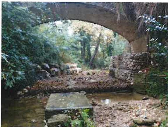
Figure 89 : le pont près de l'aqueduc renforcé par des matelas de gabions
