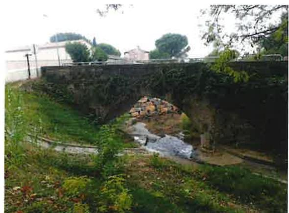
Figure 90 : le pont de la RD123 embâcle en 2014
