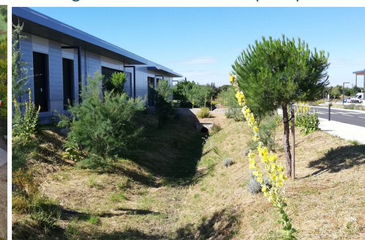
Zone Cosmo, gestion des eaux pluviales en gravitaire et intégration paysagère, un pied dans la transition écologique - Gignac
