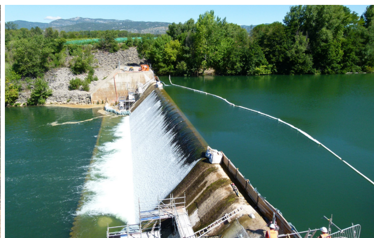
Barrage hydroélectrique de la Meuse - Gignac - Barral Thibaut - CCVH
