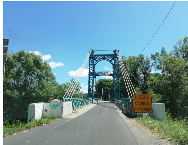
Les infrastructures de l'eau - St Bauzille de Putois
