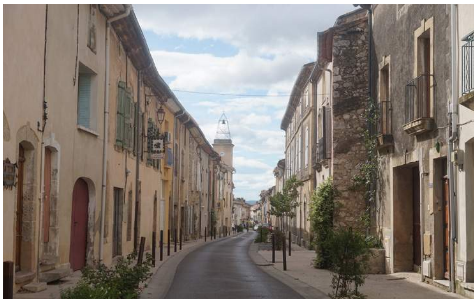
Rue centrale de Montpeyroux réaménagée - Caudex
