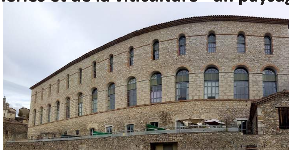
Ancienne filature de soie puis fabrique de chaux à Laroque - Caudex
