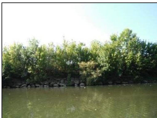
Ripisylve limitée se développant sur un enrochement
