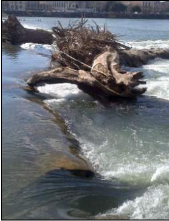
Embâcle dans la Passe à poisson de la chaussée et au pont SNCF d'Agde
