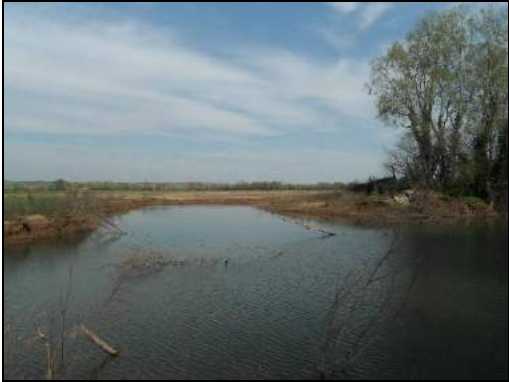
St Thibéry - Rupture d'un merlon de terre et érosion du terrain avoisinant : création d'une annexe fluviale...lors de la crue de novembre 2011
