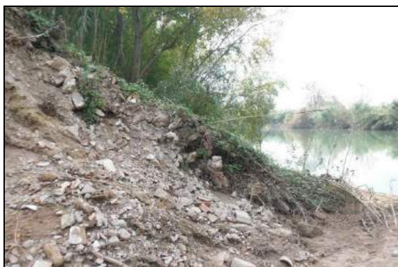
Figure 7 - dégradation d'un merlon et état de la ripisylve à Tressan
