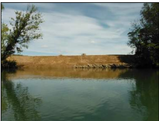
2 ans plus tard, l'érosion est comblée et une nouvelle digue est implantée
