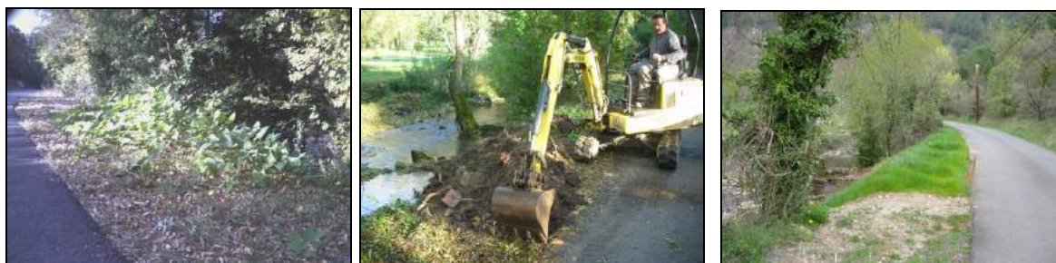
Avant travaux – pendant travaux d'extraction des rhizomes – après travaux renaturation de la berge Sur les berges de la Brèze (CC Lodévosi et Larzac)
