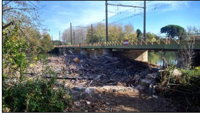
Embâcle dans la Passe à poisson de la chaussée et au pont SNCF d'Agde
