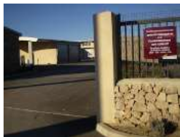
Service gestion déchets ménagers Chemin de l'Ecosite Gignac
