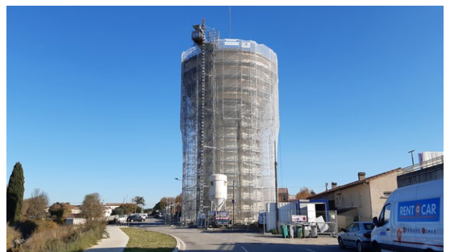
Rénovation du château d'eau de Saint-André-de-Sangonis
