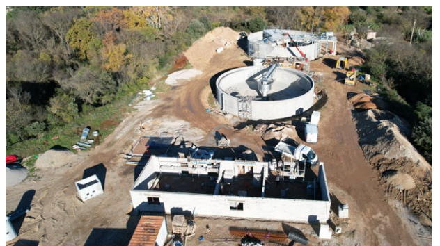
Construction de la station d'épuration d'Aniane
