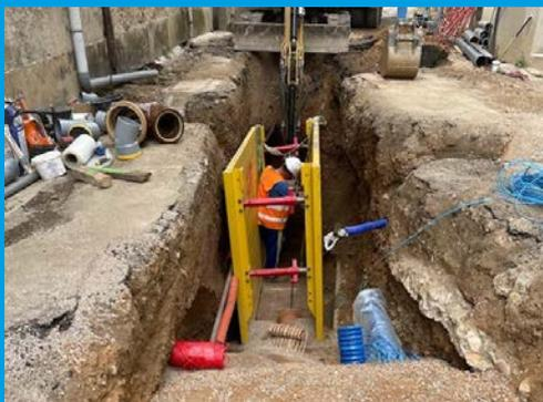
A Gignac, a également été raccordé le Centre de formation des pompiers (CEIFOR). Les travaux ont consisté à une extension du réseau d'eau potable de 880 mètres linéaires et la réalisation d'un forage dirigé sur 80 ml, c'est-à-dire à l'horizontal pour effectuer la traversée du ruisseau « le Rieutord ».
