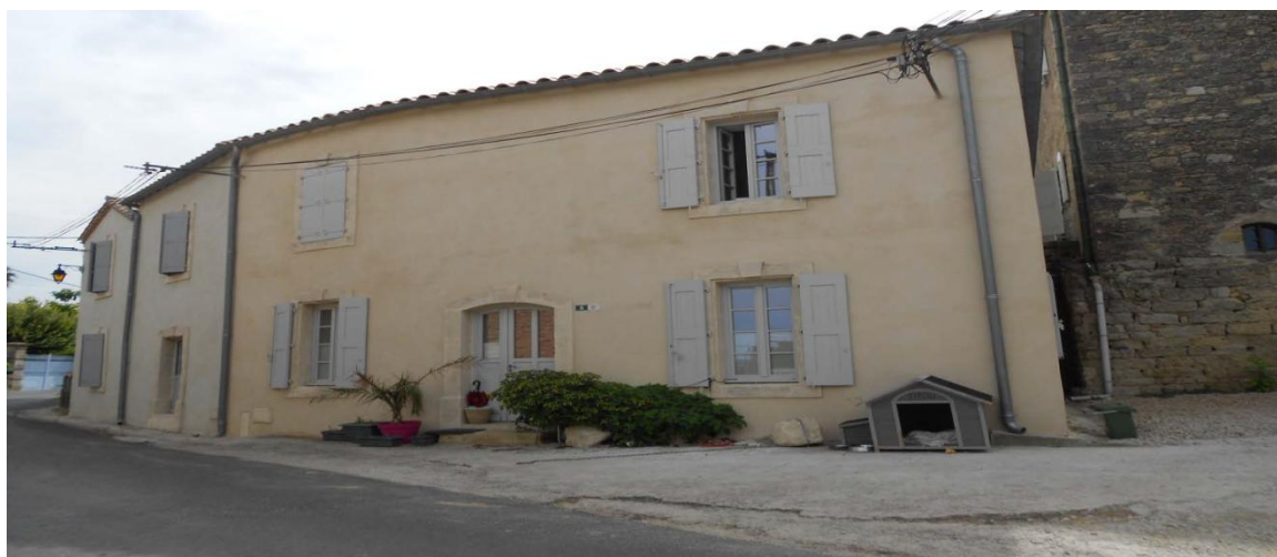
Façade SOE, accolée au 5, Av. des Condamines
