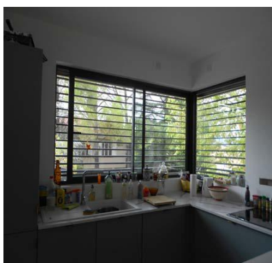
Fenêtre d'angle protégée du soleil
