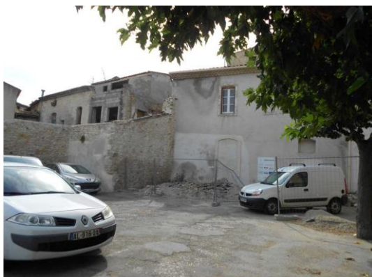
Gignac Rehabilitation mixte autour de la Mairie - en cours
