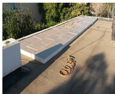
Isolation de la toiture - terrasse
