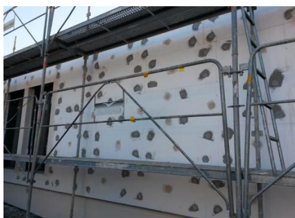
Isolation des façades
