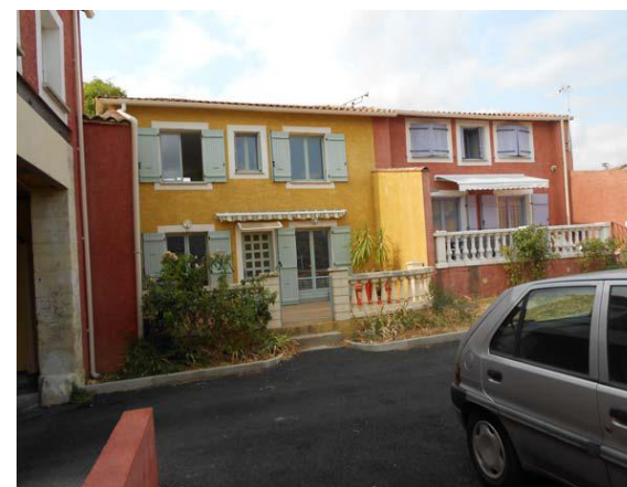
St André de Sangonis Réhabilitation privée dans un secteur d'habitat dégradé
