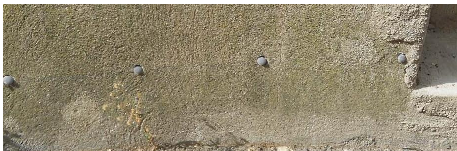
Traitement de la maçonnerie - soubassement de la façade par barrière chimique
